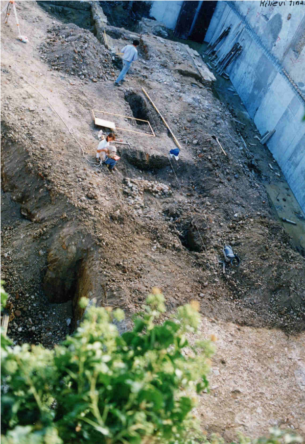
Completamento del getto in calcestruzzo per il sostegno del muro della ex filanda.
