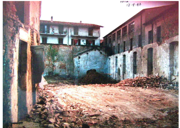
Demoliti i rustici esistenti si inizia lo scavo.
