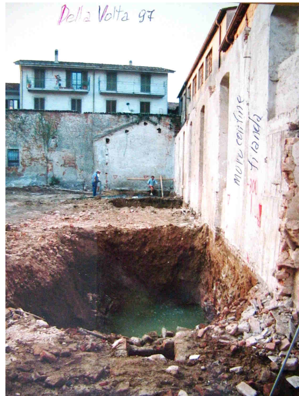
Scavi verso il muro di confine Ovest.
