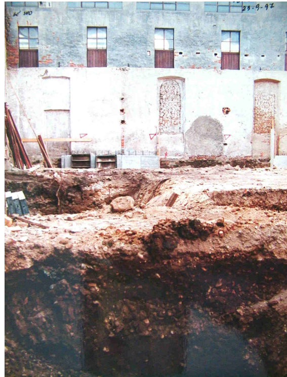
Gli scavi di assaggio su tutto il cortile.
