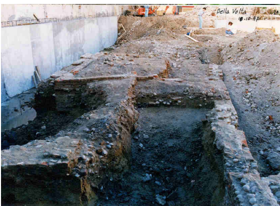
La struttura dello scarico a sinistra.
