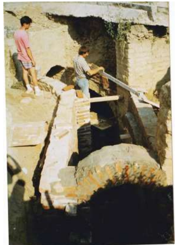
Costruzione del nuovo corridoio.
