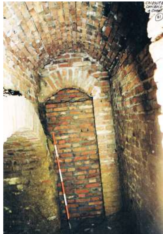
Vista dall'interno del muro di chiusura del nuovo corridoio.
