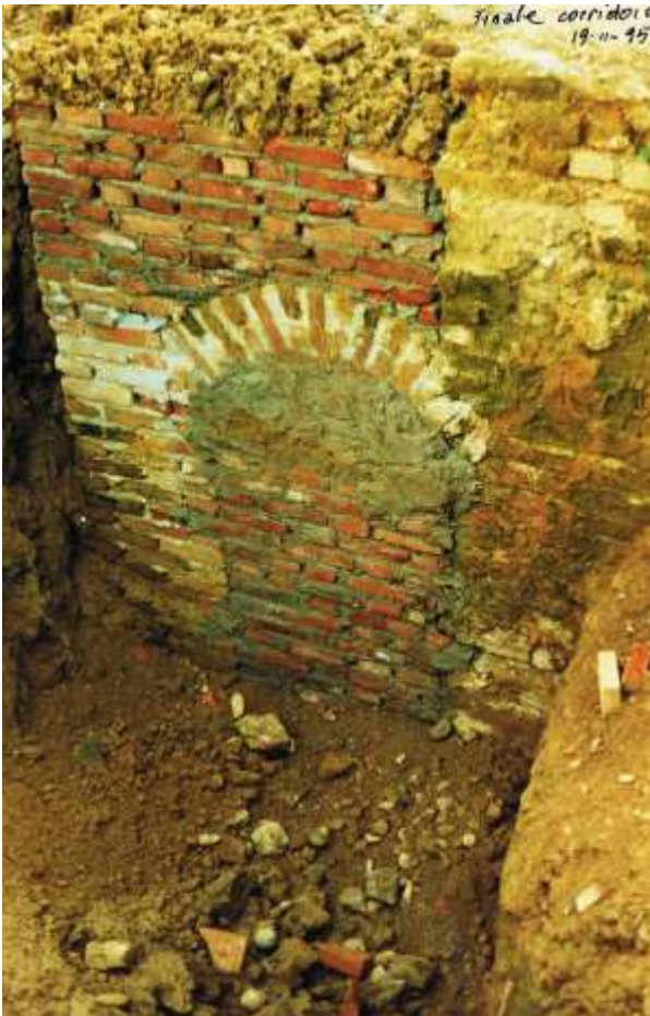
Vista dall'esterno del tamponamento finale del corridoio
