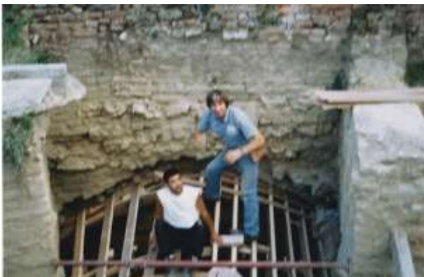
Gli operai del Comune preparano l'armatura per la nuova copertura del vano 4.
