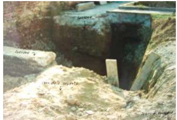
I contrafforti delle mura dopo il vano (?) 4.
