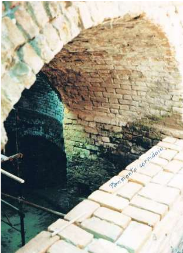
Il pavimento del nuovo tratto di corridoio
