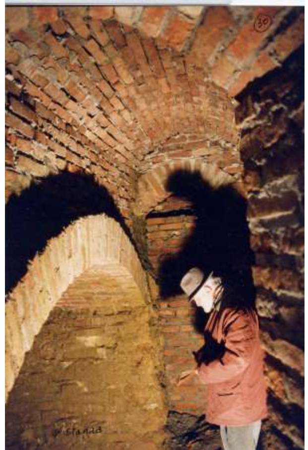
Nella foto si nota il nuovo soffitto a volta del corridoio e sul vano n° 4 e il muro di chiusura del corridoio.
