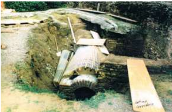
Completamento della copertura del corridoio.
