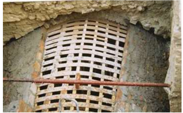
Getto di copertura del vano n° 4.
