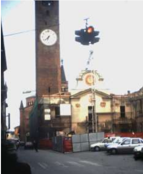
I ponteggi del cantiere attorno al palazzo comunale
