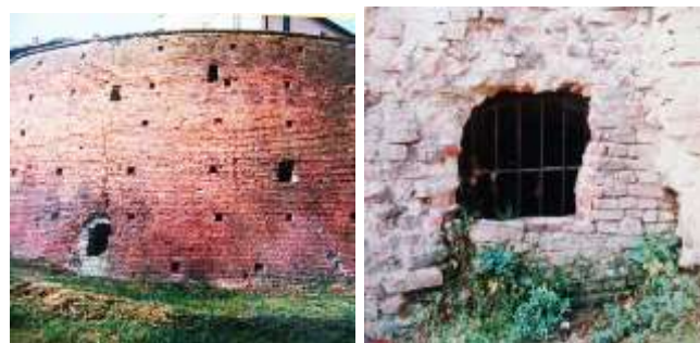
Accesso ai vani sotterranei del Bastione dalla parete sud e dalla parete Est dove il bastione si innesta con le mura.
