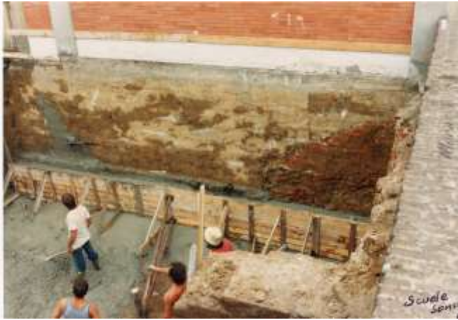
Costruzione del muro di contropinta contro le fondazioni dell'edificio scolastico realizzato negli anni 60 ed ora demolito.
