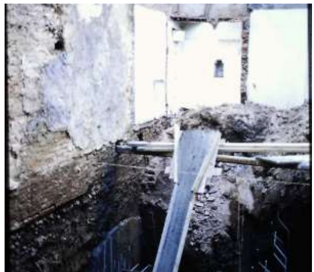
Scivolo per il getto del calcestruzzo nel vano dell'ascensore.
