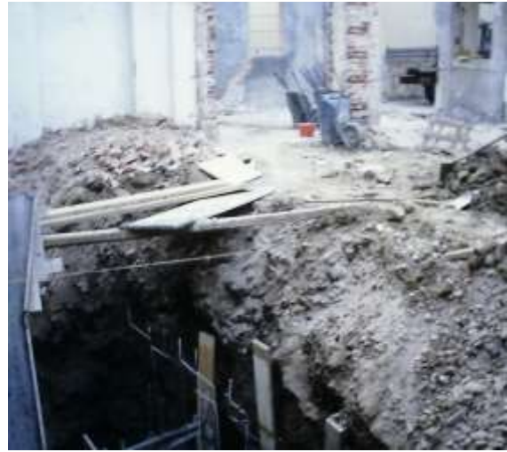
Scavo profondo effettuato per il posizionamento del vano ascensore.
