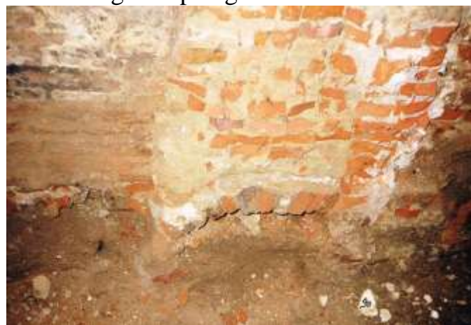
Strutture ad arco verso sud.
