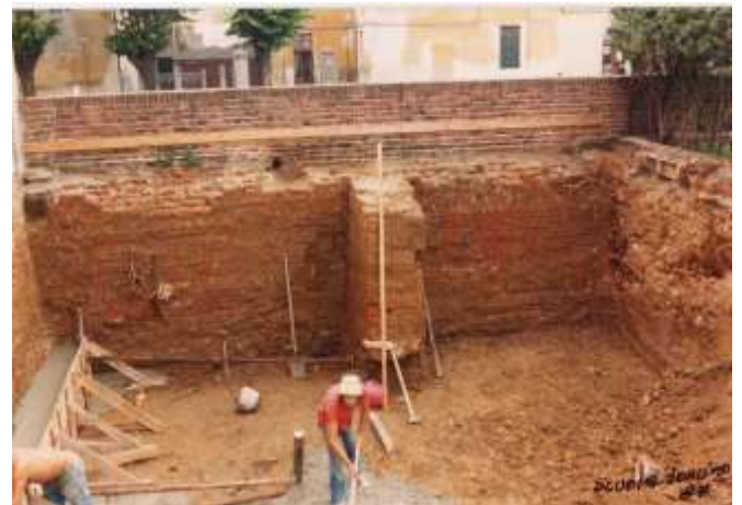
I contrafforti delle mura messi in evidenza dallo scavo in Largo Manzoni.
