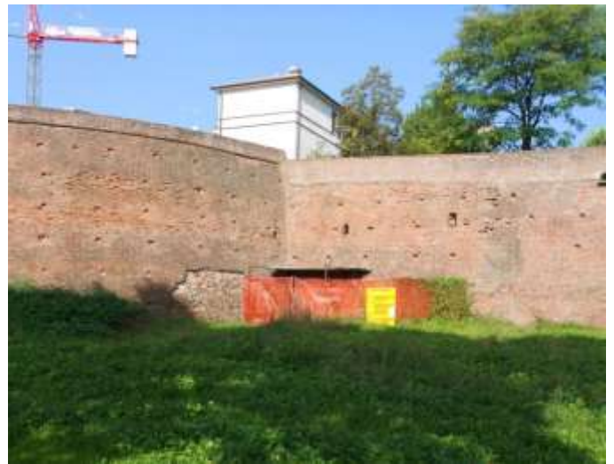
Il cantiere di "Castrun Soncini nel 2012"
