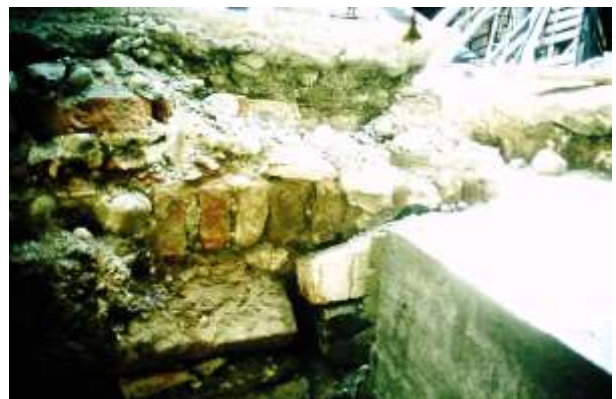
Robusto muro di fondazione contro un arco sotterraneo.
