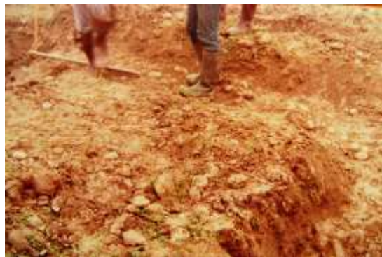
I primi scavi per individuare la larghezza della fascia di acciottolato.
