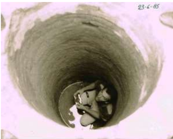
Il fotografo sul fondo del pozzo.
