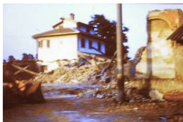
La parete con l'affresco in fase di demolizione.
