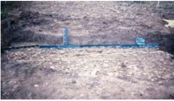
La foto che documenta la profondità dello scavo e la larghezza della strada.
