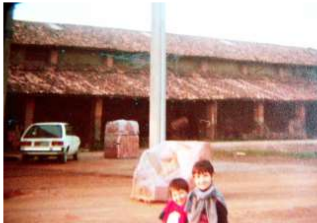
Il capannone del forno Cerioli.
