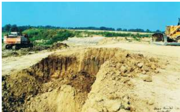
Le ruspe hanno demolito anche l'ultimo fabbricato della Cascina.
