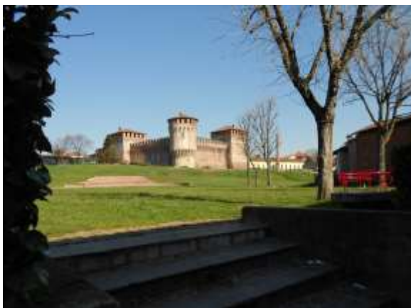
Da porta di Borgo Sotto partiva la strada per Cremona che passava a sud della Rocca volgendo verso Ovest.
