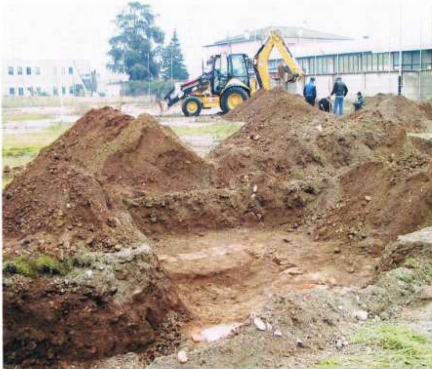
25 - La ruspa al lavoro nel campetto, per gli scavi di ispezione.
