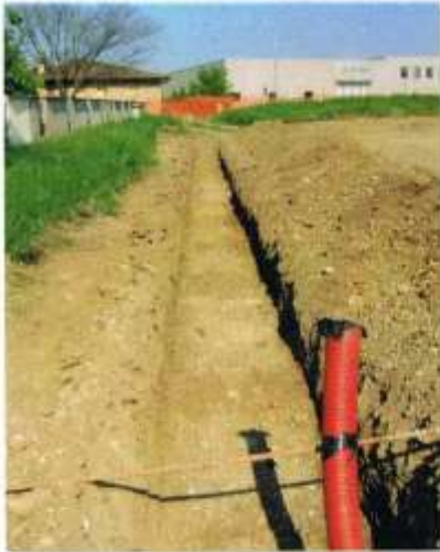
7-8 - Scavo in sezione per la costruzione del muretto di recinzione (visto da Est e da Ovest).
