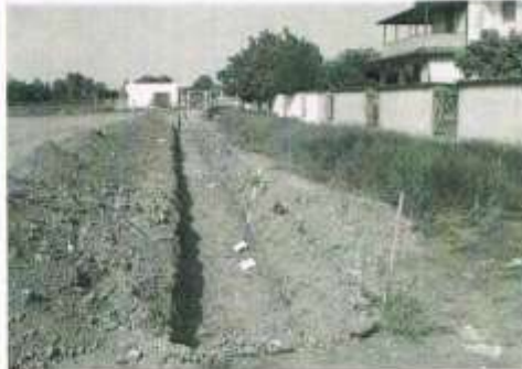
7-8 - Scavo in sezione per la costruzione del muretto di recinzione (visto da Est e da Ovest).
