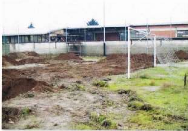
26 - Gli scavi di assaggio
