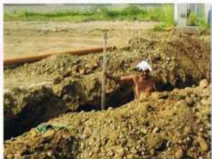
19 - Lo scavo profondo.
