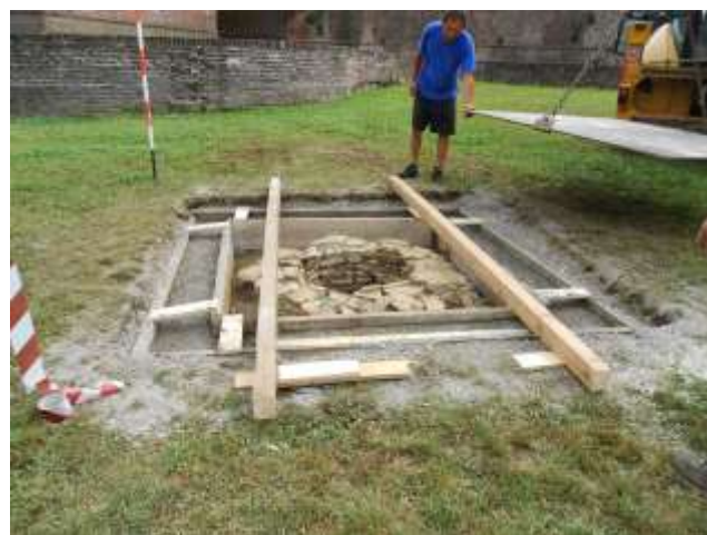
Ai lati viene gettato un cordolo di cemento sul quale verrà realizzato un muretto di mattoni.
