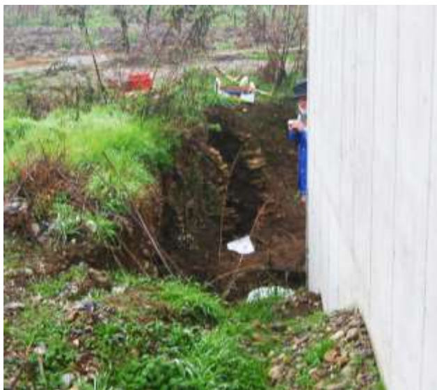
Il pozzo ai margini del muro della vasca dei liquami.
