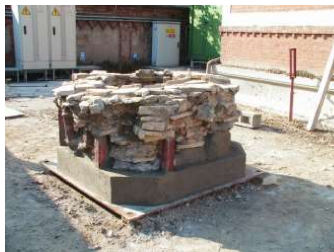
La struttura del pozzo completamente stabilizzato.
