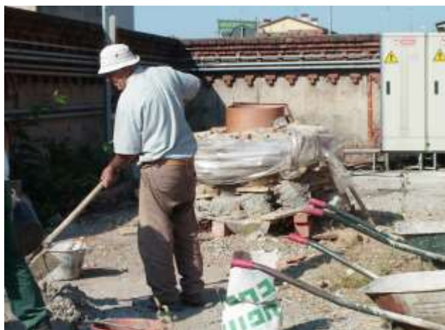
Si procede al rafforzamento della parte inferiore.
