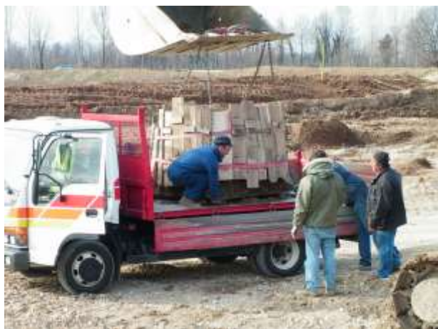
Il pozzo posato sul camion dell'Impresa Maestri.
