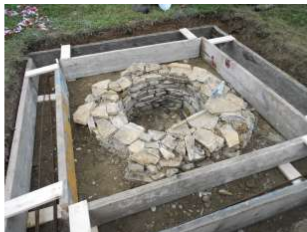
La buca è stata riempita di terra fino a 20 cm dall'orlo del pozzo ed è stata predisposta l'armatura per il getto.
