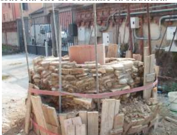
La parte superiore del manufatto è rinsaldata.
