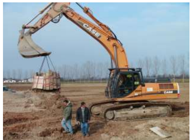
Prelievo e trasporto del pozzo fuori dal cantiere.
