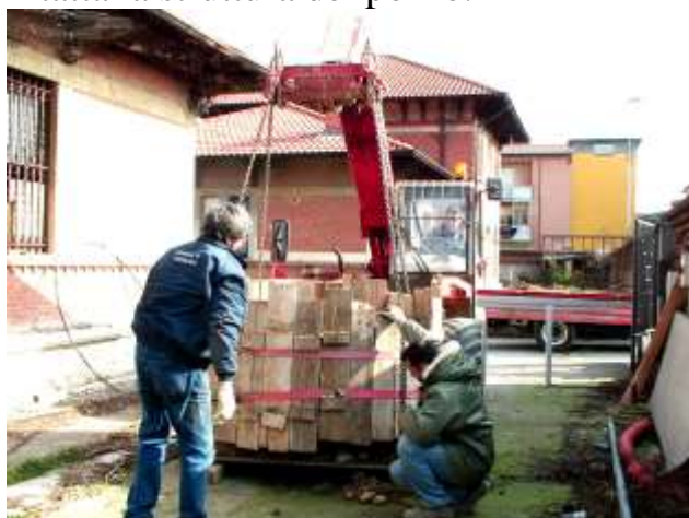
Il pozzo posato a terra.
