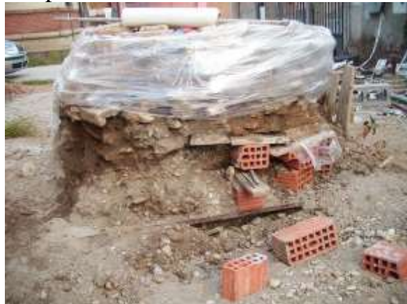
Tolte le assi di contenimento.
