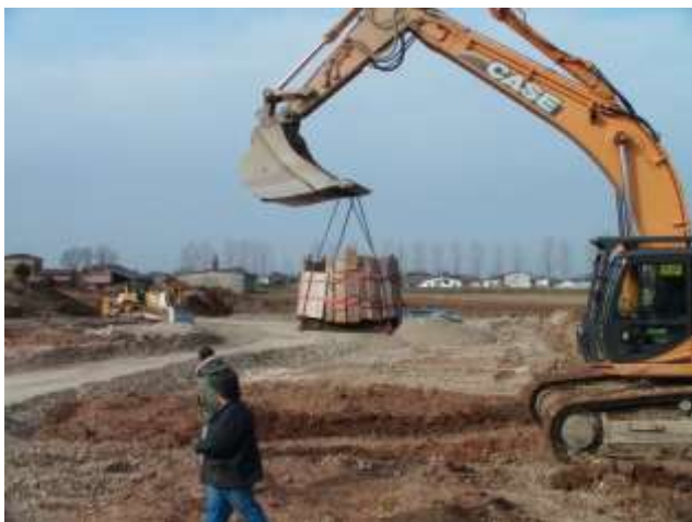
Prelievo del pozzo n° 1
